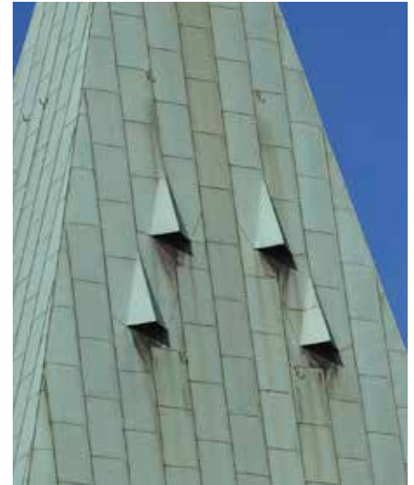
Die „Schalllöcher“ im Glockenturm
